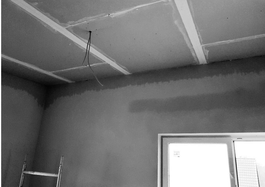
**Bild 2:** Standard-Ziegelbau (2017) in der Bauphase; durch Tauwasser auf dem Putz zeichnen sich Wärmebrücken ab
