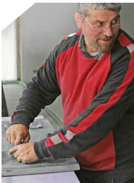
▲ Einsetzen der Agraffen in einem auf Gehrung geschnittenen Abschlussstein
