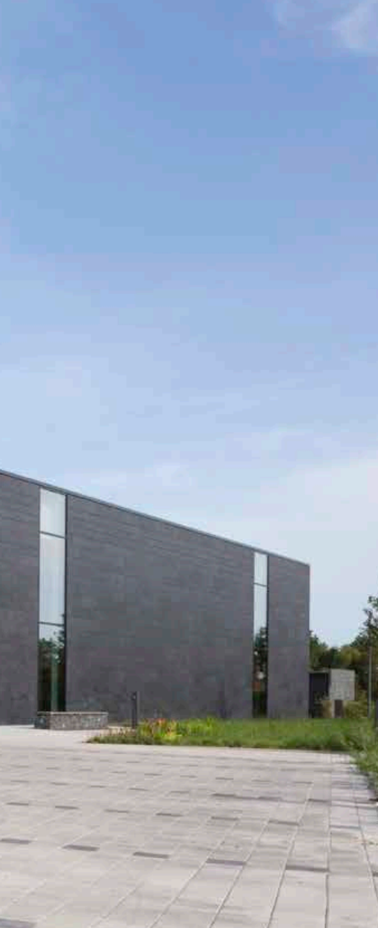
▲ Repräsentative Schieferfassade mit symmetrischer Deckung am Neubau der Firma König in Karlsruhe
