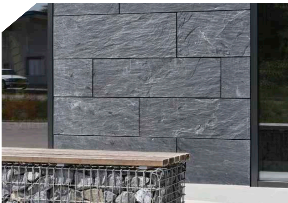
► Edle Optik im Detail: Flächenbetonte Fassade mit ebenen Fensterfronten
