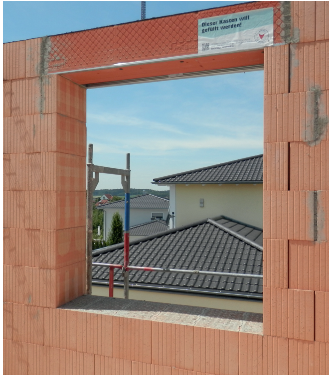
Abb. 4: Fensteröffnung in einer gemauerten Außenwand
