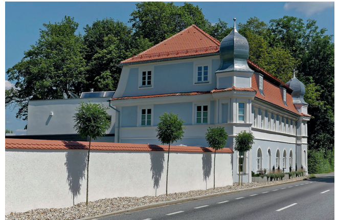
Bild 2: Gebäude nach der Sanierung, Straßenansicht
