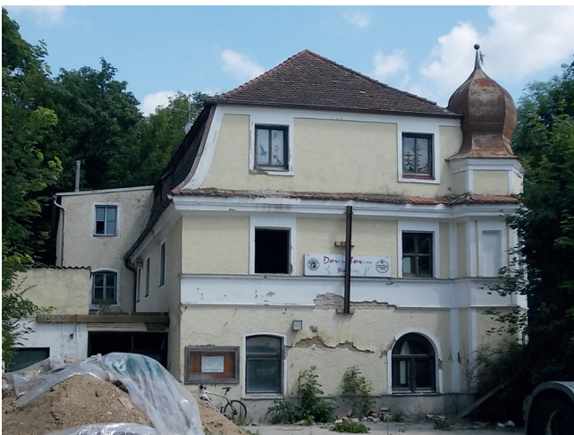
Bild 1: Gebäude vor der Sanierung, Giebel mit rückwärtigen Anbauten
