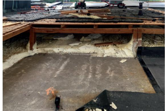
**Bild 3:** Feuchte- und schadstoffbelastete Dachkonstruktion
