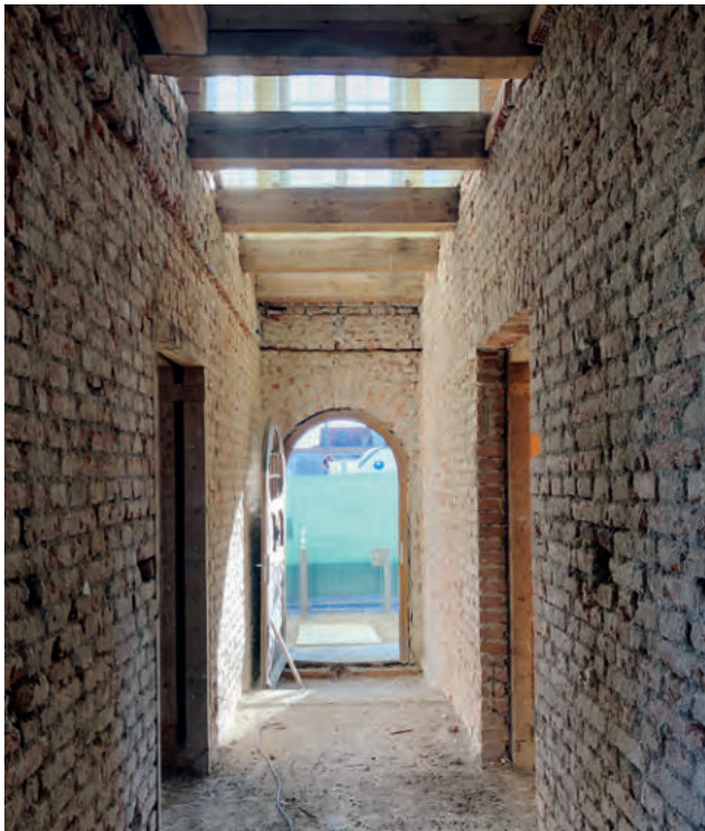
Bild 10: Ziegelwand alt (Foto: Stefan Dinkel)
