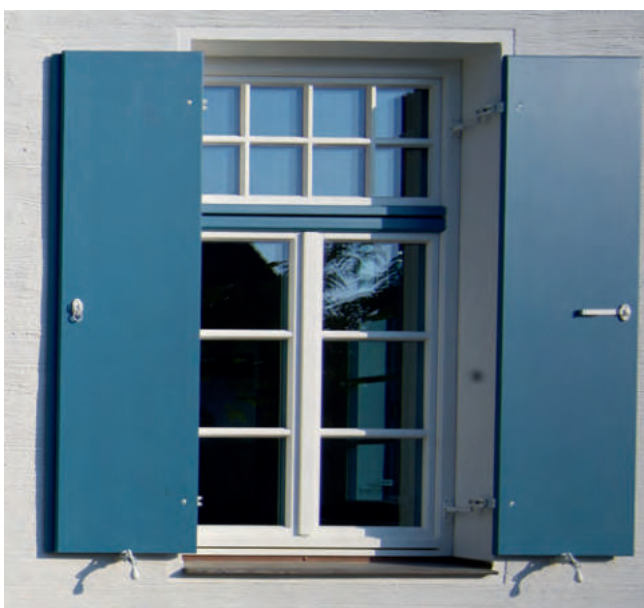
Bild 15: Fenster nach Sanierung (Foto: Bodo Mertoglu)
