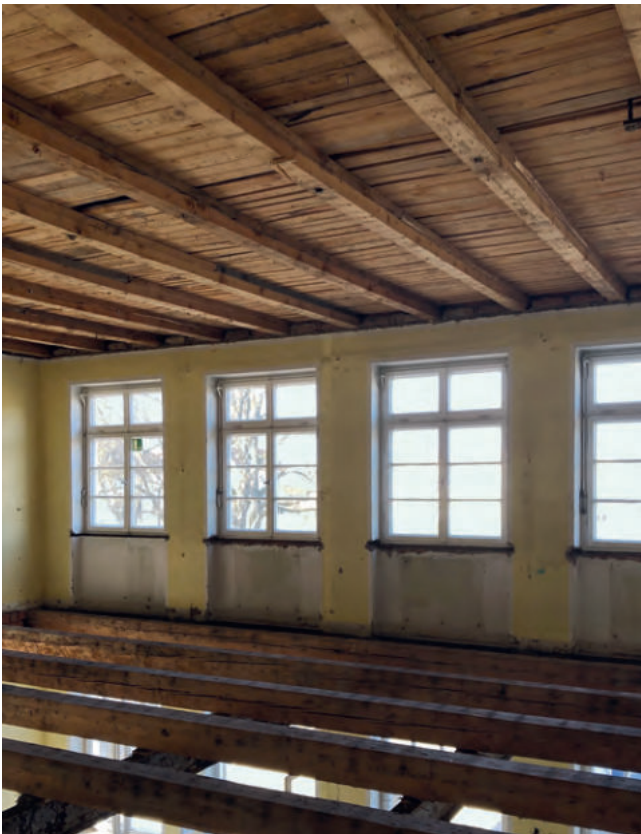
Bild 12 und 13: Entkerntes Gebäude (Foto: Stefan Dinkel)
