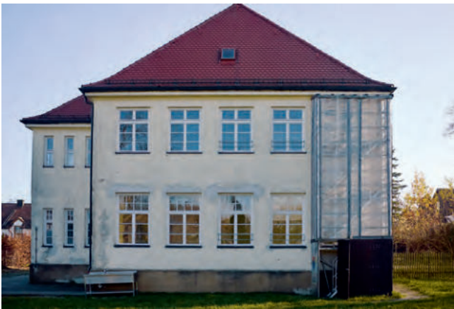
Bild 1 und 2: Schulhaus vor der Sanierung mit Fluchttreppenhaus (Foto: Stefan Dinkel)
