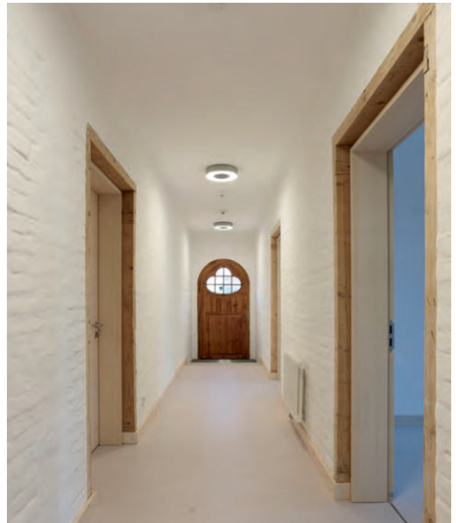
Bild 11: Ziegelwand neu (Foto: Bodo Mertoglu)
