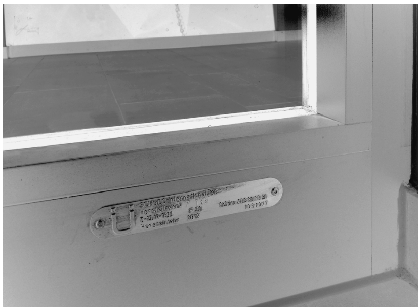
Bild 6: Kennzeichnungsschild einer Brandschutzverglasung (Quelle: mhd-Brandschutz)
