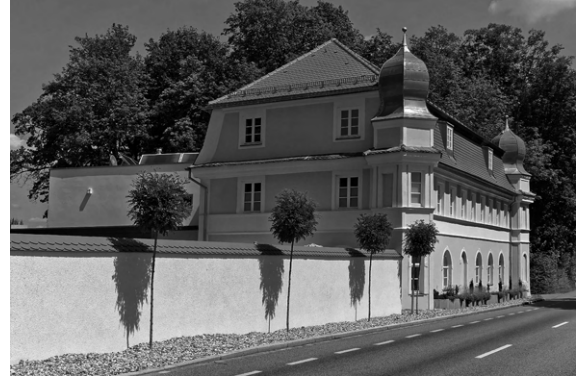
Bild 2: Gebäude nach der Sanierung, Straßenseite
