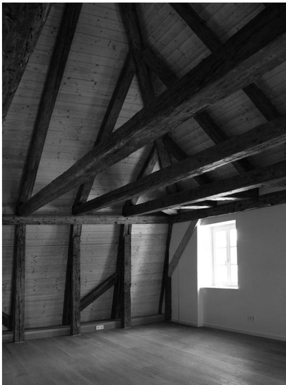
Bild 7 und 8: Dachraum von innen, nach der Sanierung
