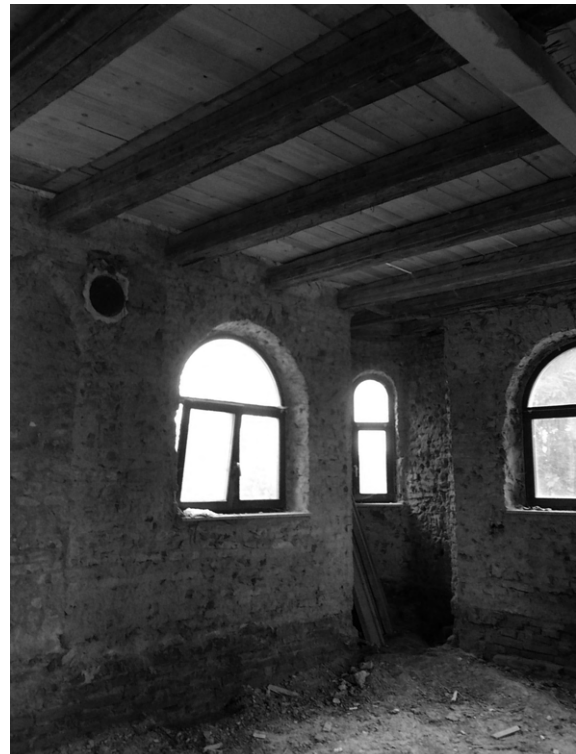
Bild 3: Bestandsaußenwände von innen
