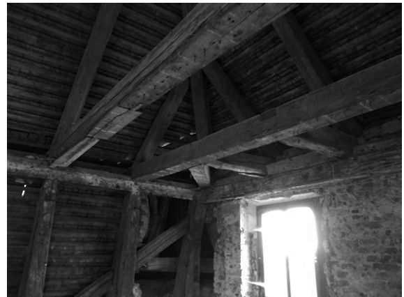
Bild 5 und 6: Dachraum von innen, vor der Sanierung
